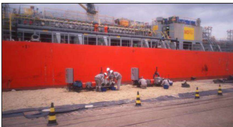
Foto 2: Kits em montagem sobre camada de areia de contenção e lona plástica.
