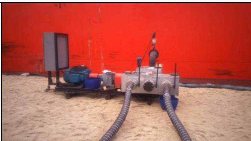
Foto 1: Unidade do KIT de Carregamento sem gerador.
