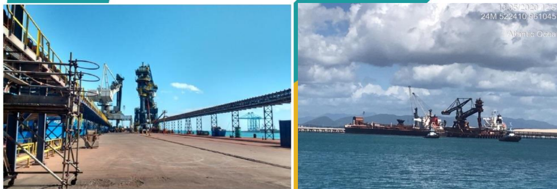
Figura 2 – Ponte de acesso.
