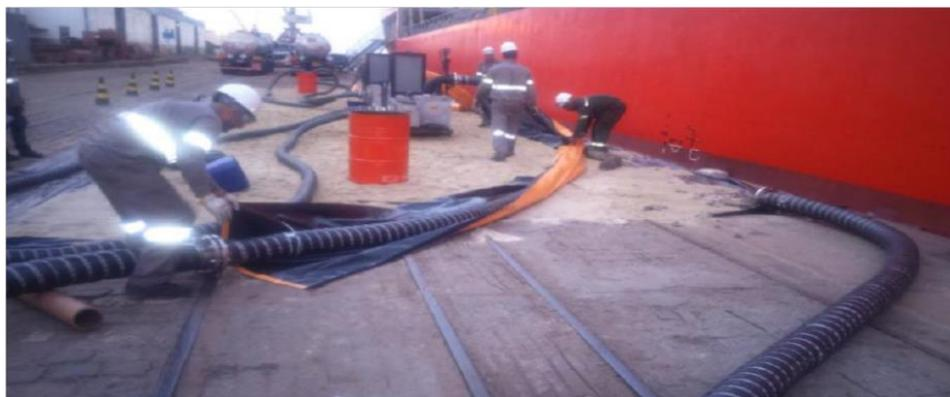
*Foto 4: Encapsular mangote com lona adaptada com velcro.*
