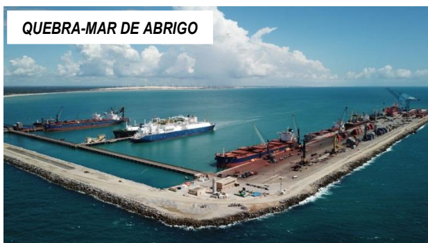
Figura 10 - Quebra-mar de Abrigo
